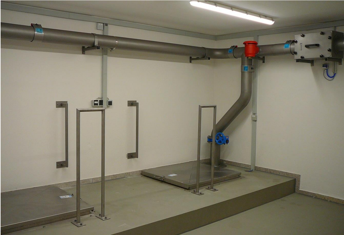
Neue Abdeckung der beiden Wasserkammern
